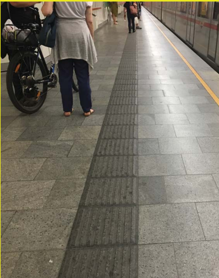
Marcaj tactil de direcționare, de interior, Bilbao
