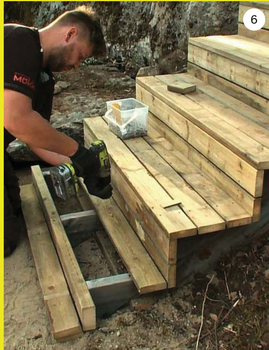
Referință scară, structură de lemn, trepte de lemn
